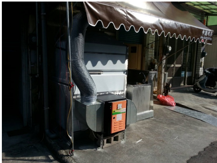
彰化縣溪湖鎮彰水路三段51X號靜電機安裝
