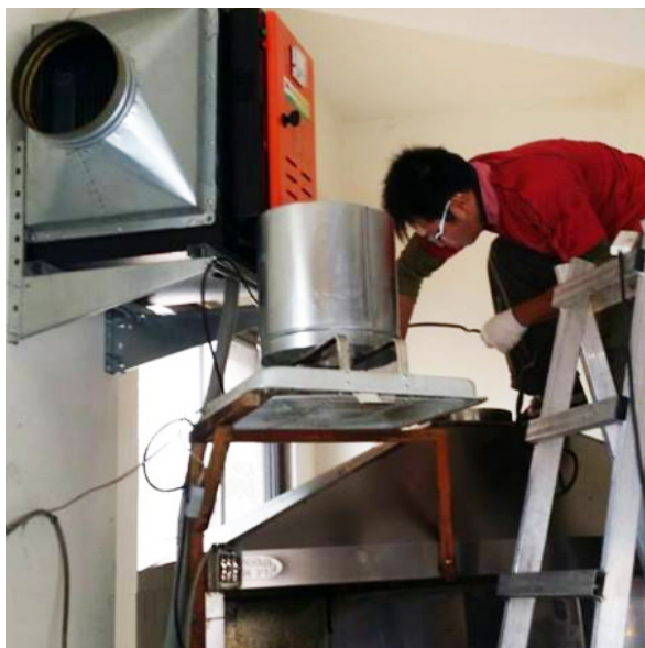
靜電機安裝工程
